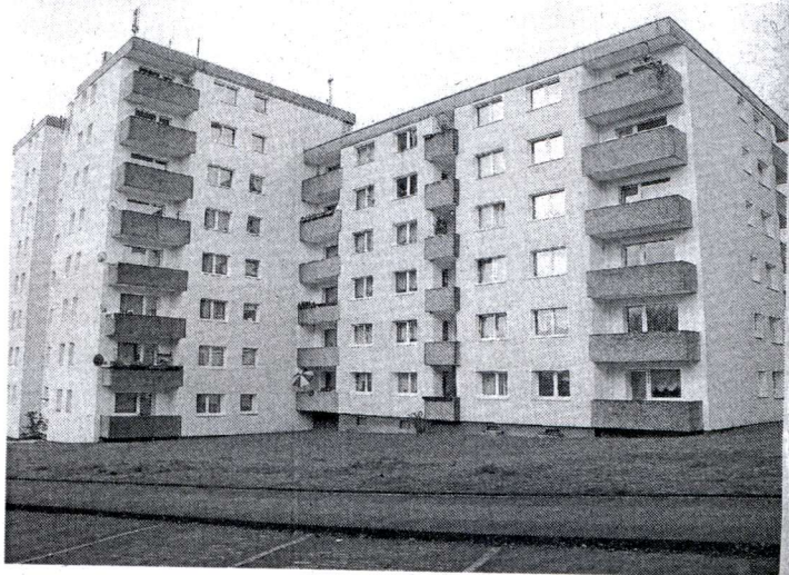
Rund zwei Millionen Euro hat die ibs-Immobiliengruppe in die Sanierung der Wohnanlage Köttershöhe gesteckt.
